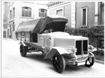
Büssing Typ II (1914): Erster Lkw mit Kardan, elektrischen Frontscheinwerfern und Gas-Positionslampen.
